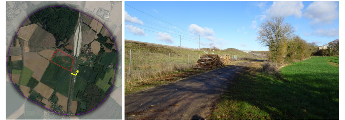
Figure 190 : Photographie du remblai lié au passage de la LGV Sud Europe Atlantique (Crédit photo : NCA Environnement)
